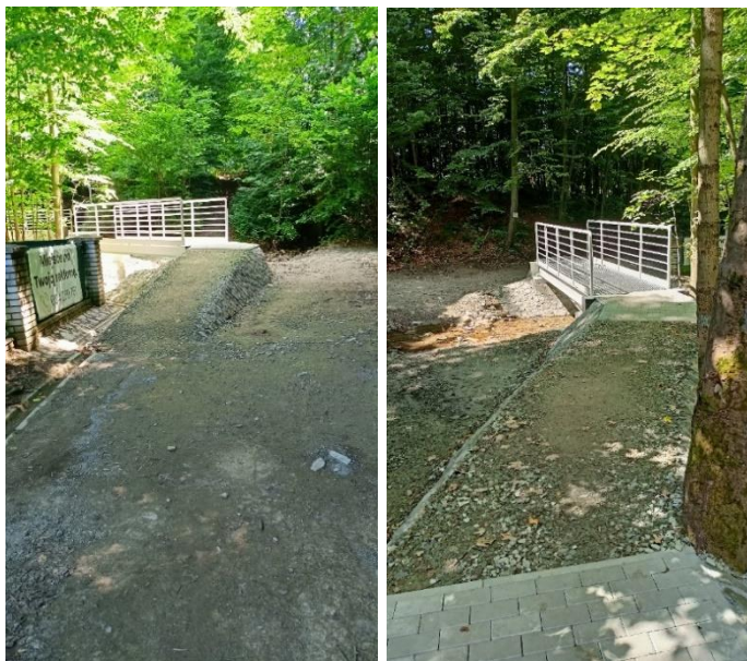
Budowa kładek w ciągu potoku Gościradowiec
