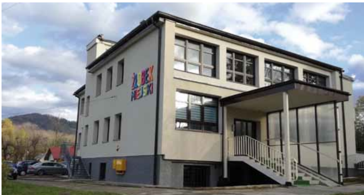
Ogromny zakres prac za nami, sporo przed nami. Żłobek Miejski.
