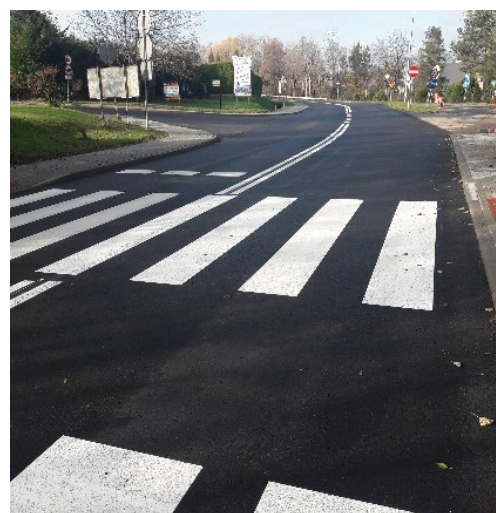
Wyremontowane drogi i chodniki przy ulicach: Szpitalnej, Źródlanej, Cieszyńskiej
