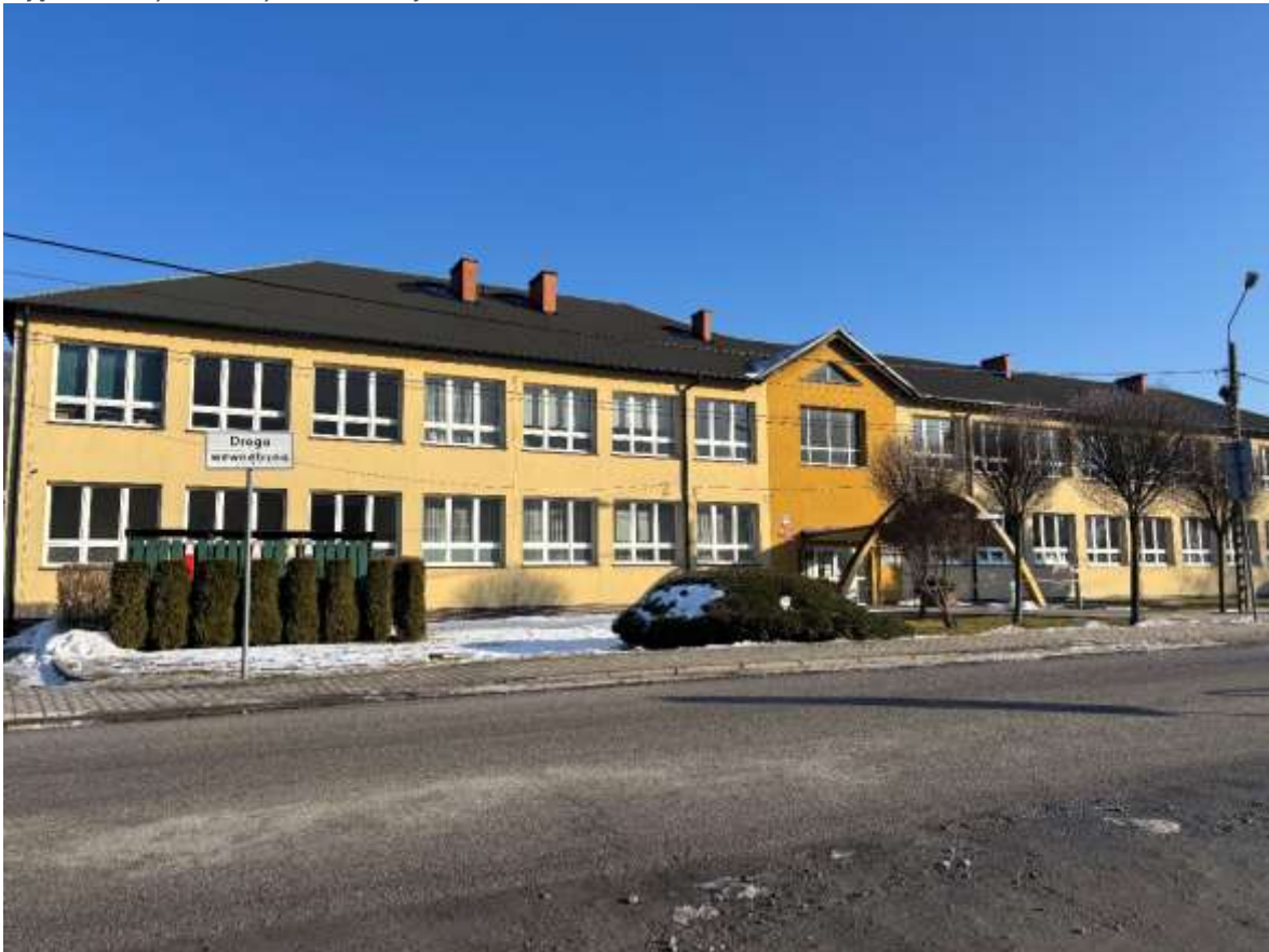
Zdjęcie 12 Budynek Szkoły Podstawowej nr 3 – Ustroń Polana
