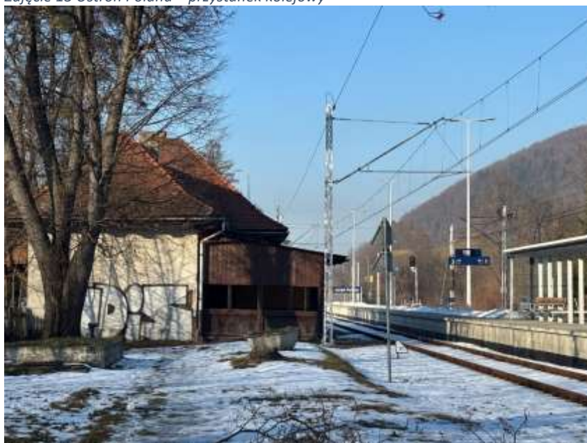
Zdjęcie 13 Ustroń Polana – przystanek kolejowy
